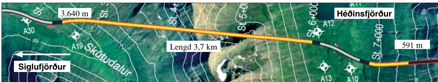
Staða framkvæmda við Héðinsfjarðargöng 21. júlí. 2008. Sprengingum frá Siglufirði til Héðinsfjarðar lauk 21. mars 2008.
