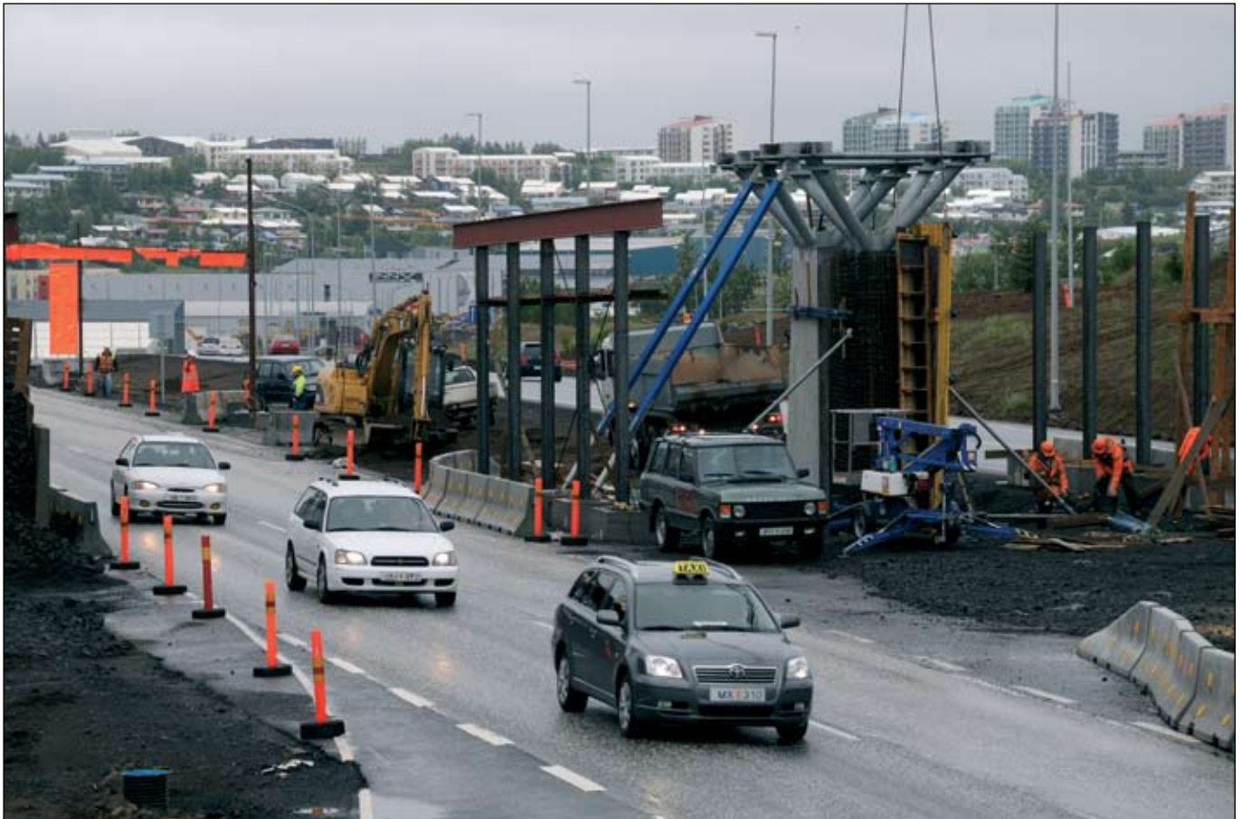
Reykjanesbraut (41), framkvæmdir við mislæg gatnamót við Arnarnesveg. Verktaki er Suðurverk hf.
